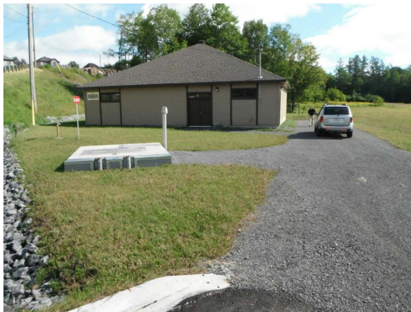
Figure 3.8 Bâtiment abritant les composants du système Rotofix®
